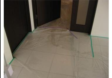
3通りのシミ抜きテストをして、結果としては、1の方法で薄くなってきたので、シミ抜き剤を塗布し、湿布して3時間くらい放置後に除去したら、全体的にタソス本来の白さが戻ってきました。
