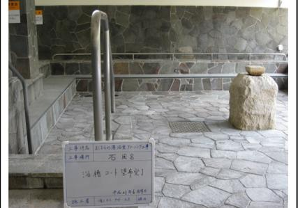
だけでは汚れが取れないです。今回は、高圧洗浄に砂を添加して吹き付けるサンドブラスト機材が非常に役に立ちました。温泉施設は、その他、ダイヤモンドブラシ、振動サンダー等を使用し、洗浄というよりも工事に近い格好で何とか無事に終わることが出来ました。今回、工期の最後に仕上げ洗浄のような扱いで入りましたが、工事の内容からすると、工期の始めに、絡みのない状態で施工したいところでした。
