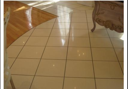
くないので、1工程から2工程を大理石よりも時間をかけて研磨していくと、光沢が戻ってきます。ライトの反射がシッカリと見えてきました。セラミックタイルも白色となると汚れも目立つので、定期的な洗浄や研磨は必要になってきますね。最近、よく見かけるスチームモップなどで毎日の清掃をすると清潔さを維持できるかと思ひます。
