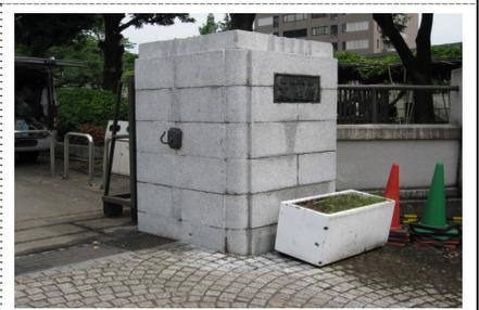
し、他の洗剤分が入り込みやすくします。その後酸性洗剤を塗布し、目地まわりのエフロを除去し、最後に黒いカビ除去用に塩素系洗剤を塗布し、写真のように仕上げました。
