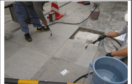
4. 浸透性コート後再度強制乾燥
