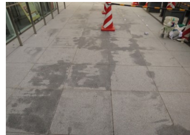
1. 雨水による裏面からの吸上げ
