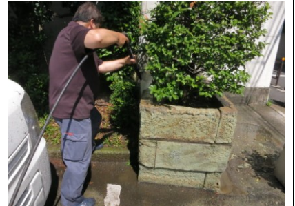
2. 洗剤塗布後、高圧洗浄
