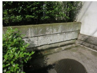
1. 大谷石の汚れと劣化
