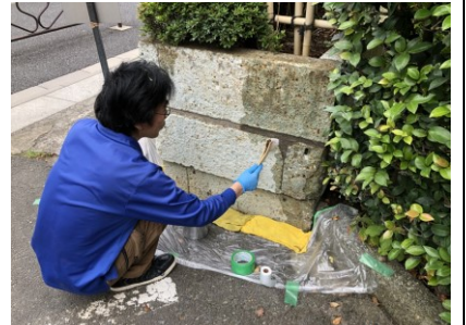
4. 石の吸水性を抑えるコート剤と塗布する
