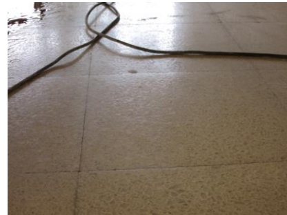
2. 表層の凹凸状態
