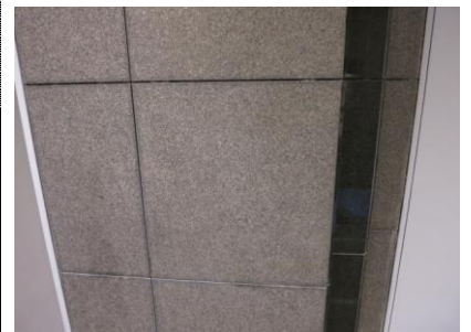
4. 洗浄施工完了後
