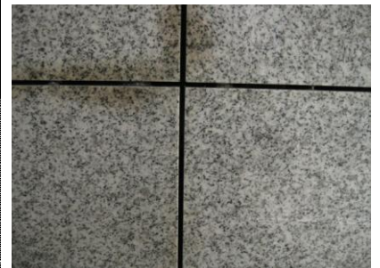
4. シミ抜き施工完了後
