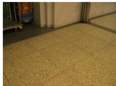
4. 油シミ抜き完了後
