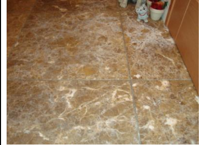
漏水数日後のエフロ状態
