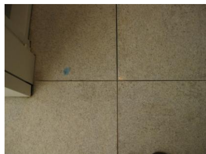
4. 油シミ抜き完了後
