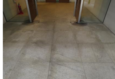
1. 石の裏面から吸上げによる濡れ色
