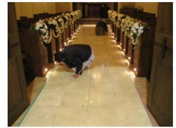
色も映え、電球のライトもくっきりとしてきました。最後に#8000とパフ仕上げして、研磨の砥ぎ粉を拭き上げ、翌日に防汚コートを塗布して完了しました。
