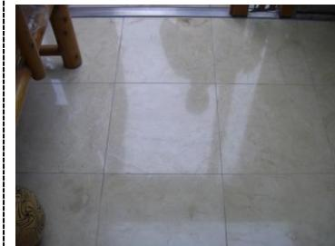
るようです。対処は御影石の様にケレンで削ると石の表面のツヤが飛ぶので、バフやダイヤモンド研磨でエフロを除去していきます。
