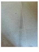
とくに、テープを貼って時間の経ったものは、抜くのにも時間が掛かりま で養生するのですが、それを固定するテープで、右のようなシミできます。 建築時や引越し時に 石を保護するために、必ず、コンパネやクッション材
