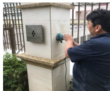
3. 表層の研磨施工
