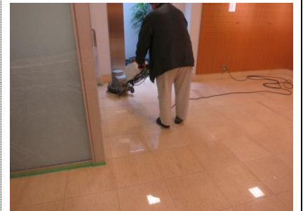
4. 浸透性コート塗布後のパフ
