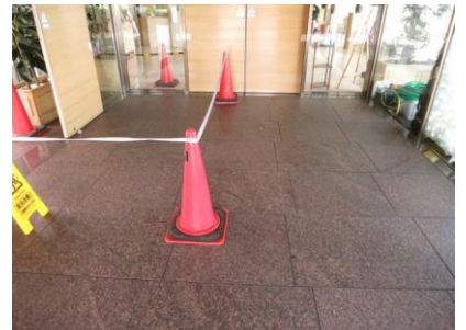
4. ウェットコート塗布完了
