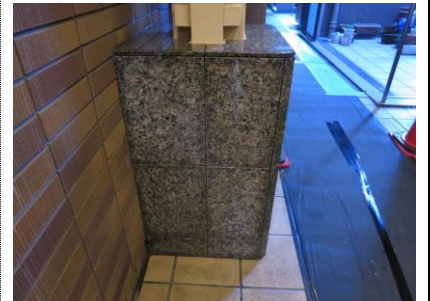
4. シミ抜き施工完了後
