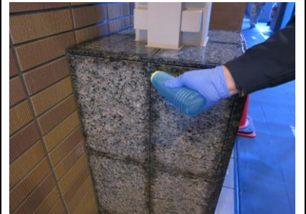
2. シミ除去剤注入
