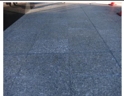
4. 全体へも浸透性コート施工後
