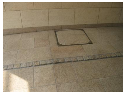
4. シミ抜き施工完了後
