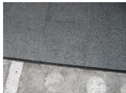
4. 油シミ抜き完了後
