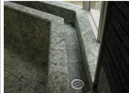
洗浄施工後、浸透性コート塗布
