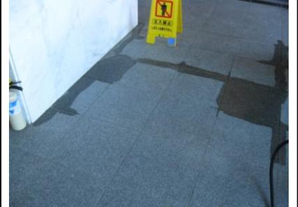
防止剤を塗布します。十分にコート剤を吸わせた後に残ったコート剤は綺麗に拭きとり、最後にシミの出ている部分を再度、トーチを使って強制乾燥させていきます。この後に1週間位様子を見て、再発が無ければ、浸透層が出来ているので、濡れ色の再発は大分減るかと思います。
