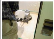
コツです。シミ抜き後は、 ダイヤモンド研磨を4工程 ほど行い光沢を復元し、今 後にシミが付きにくくなる ように、石材用のフッ素樹 脂系のトップコートで処理 し完了しました。
