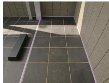
1. 施工箇所を区切る
